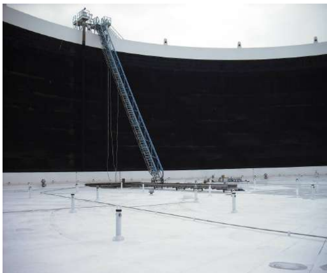
Резервуар с плавающим пантоном компании ENEOS.
